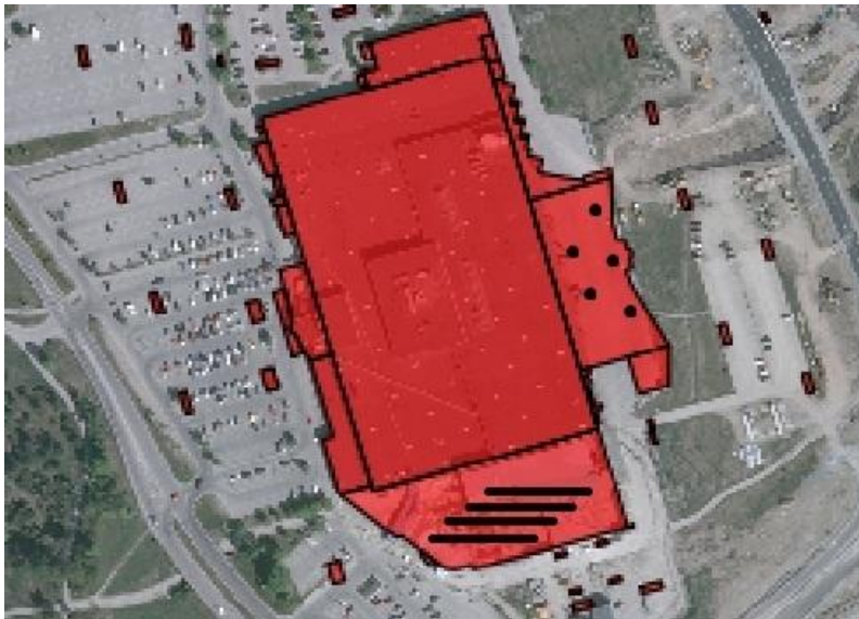
Figur 17. Systemets placering på Gränby centrum's tak.
