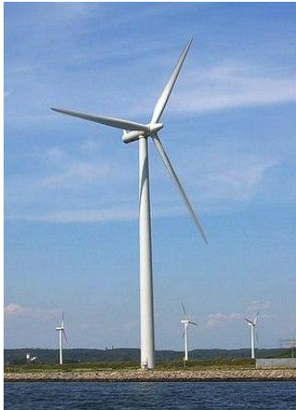
Figur 9. Ett typiskt vindkraftverk med horisontell axel. (Bildkälla: Windturbine installer)
